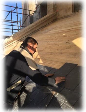
pose des ardoises
